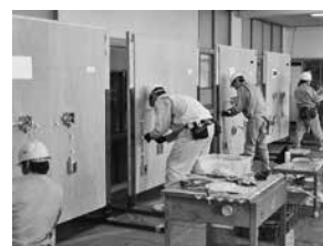
電気科：電気工事
